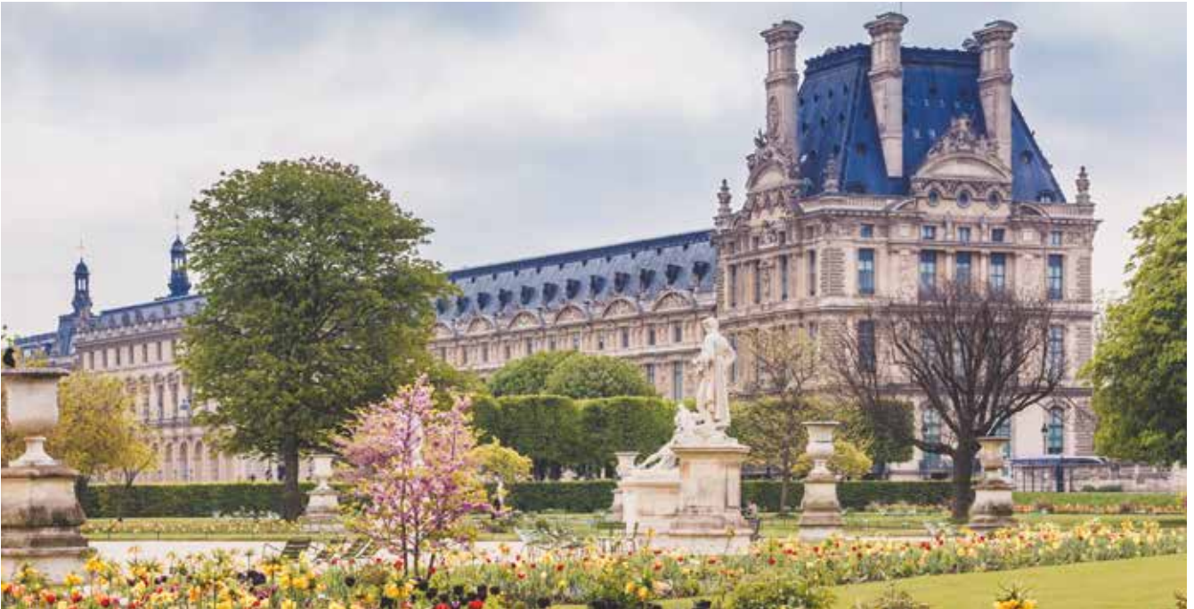
Jardin des Tuileries, rue de Rivoli
